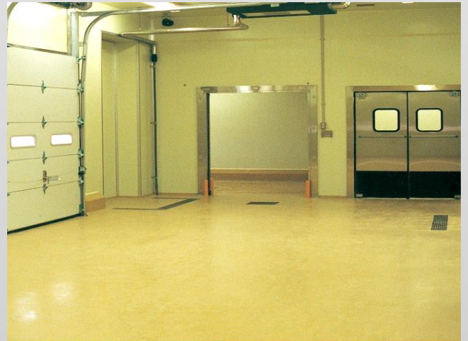
導電性塗床（VESSEL製）
