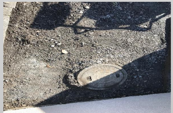
②排水柵廻りアスファルト撤去状況
