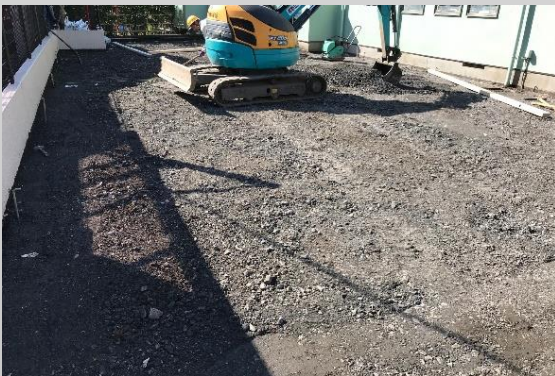
①既存アスファルト撤去
