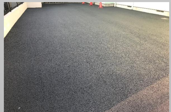
④アスファルト舗装完成状況
