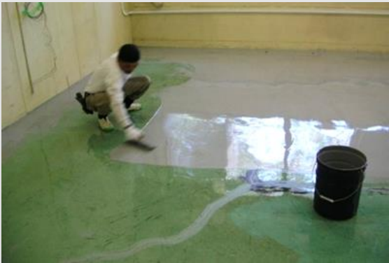
③塗床 プライマー+下塗り+上塗り
