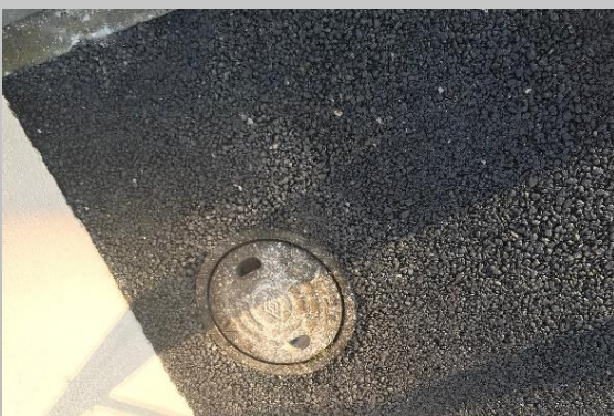
③アスファルト舗装完成状況
