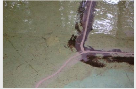
②下地処理 クラック箇所の補修 既存塗床の剥離
